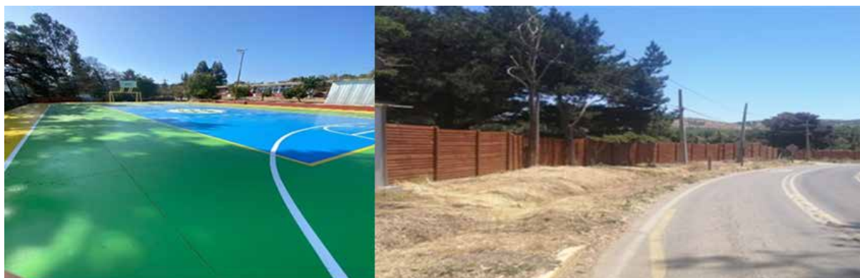
Imagen N°39: Obras Ejecutadas Escuela Básica Cristina Durán, 2025.
