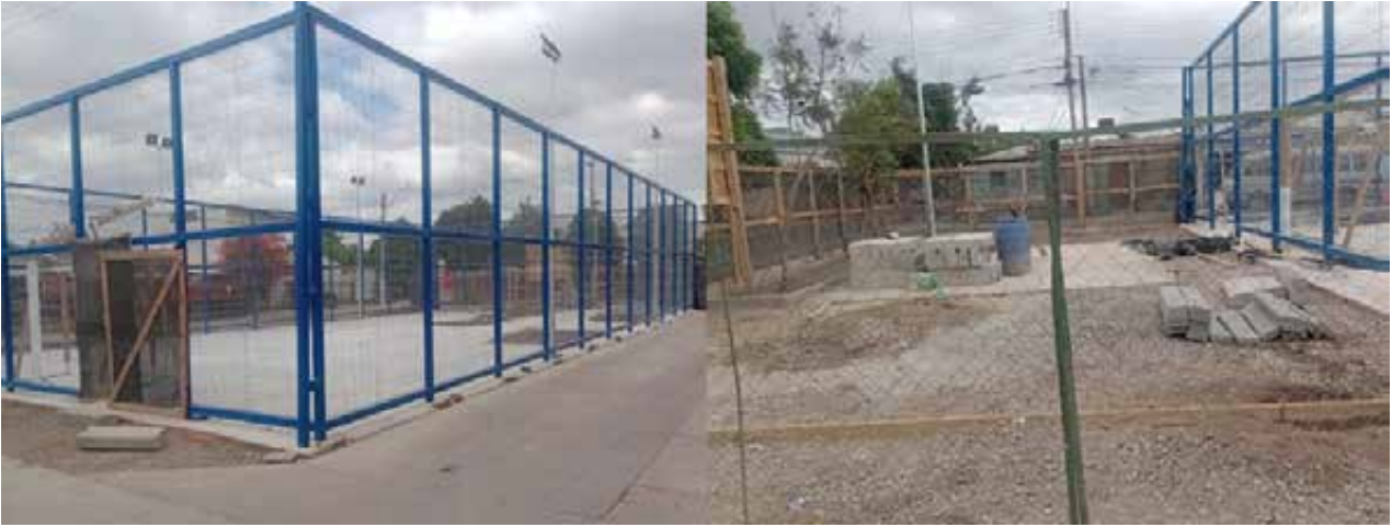
Imagen N°15: Avance de Construcción Superficie Deportiva y Plaza Los Lúcumos, 2025.
