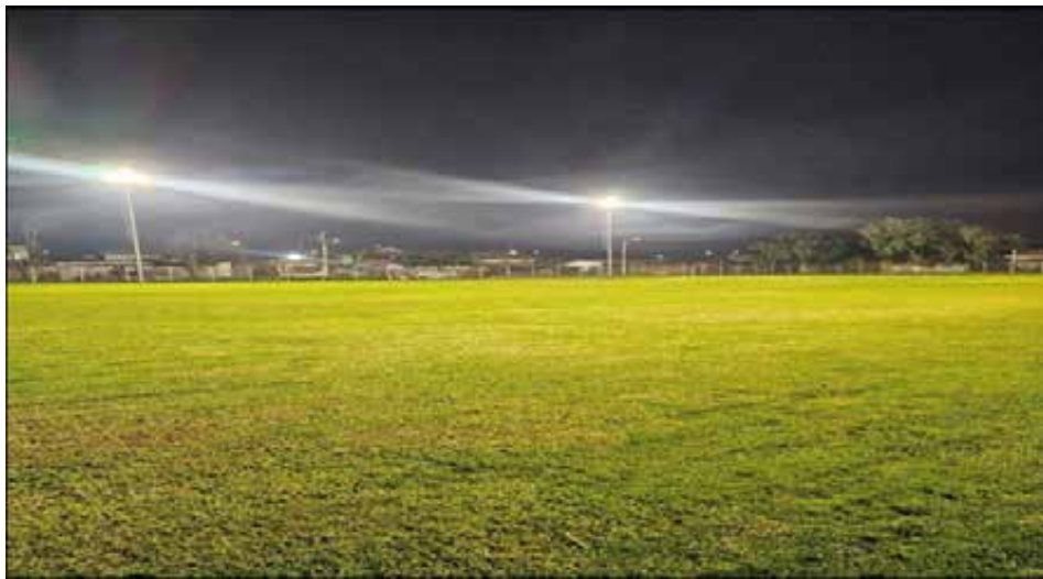
Imagen N°14: Reposición Cierre Perimetral e Iluminación Cancha Club Nacional, noviembre 2025.
