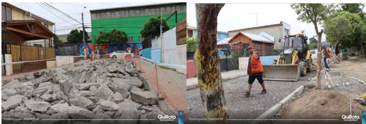
Imagen N°38: Ejecución de Obras Pavimento Población Diego Portales, diciembre 2025.
